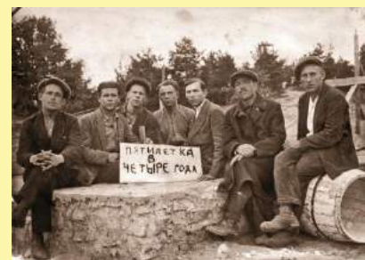
Строители Балахнинского целлюлозно-бумажного комбината. 1930 год
