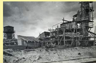
Строительство завода «Сокол». 1930-е годы
