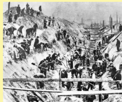
Земляные работы на площадке строительства ГАЗ. 1930 год.
